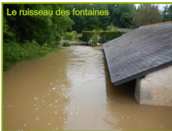
St bohaire : pic de crue le 1 er juin 2016
