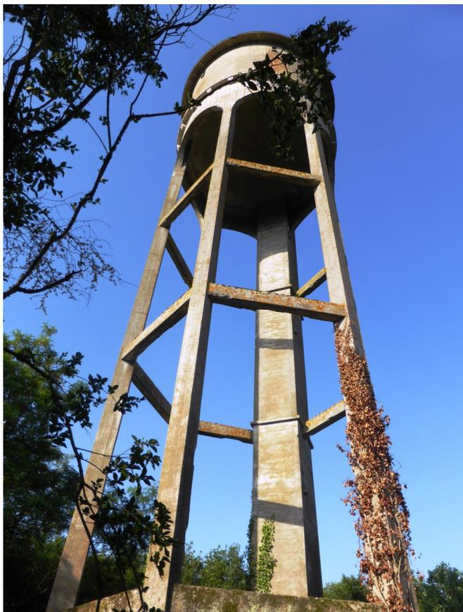
Les plans du château d'eau et du captage furent dressés par le cabinet ETUR, 42 rue du mail à Blois, le 28 décembre 1936. La commande pour l'adduction et la distribution d'eau a porté sur une maison de maintenance, l'entrée du captage sous le coteau, le mécanisme de pompage, les écoulements de condensation, l'édification d'un château d'eau entre la cote 85,76 et le niveau d'eau maximum dans le réservoir à celle de 115,37 et l'alimentation électrique des pompes.
