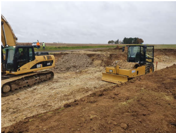
ZTHA2 Grivelière aval » en cours de travaux
