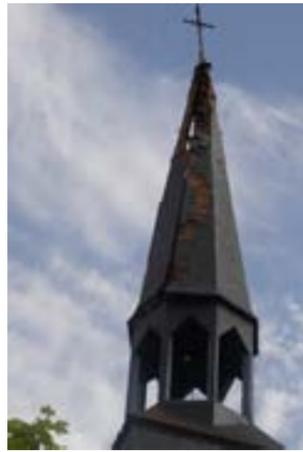
19- et 20-La flèche est explosée du côté de la maison de retraite, le jour est visible au travers © photo JLR
