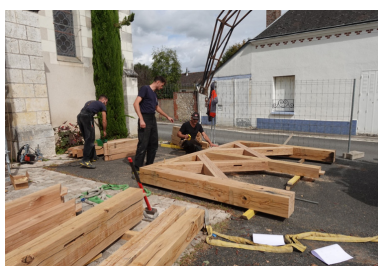
Reconstruction à neuf du campanaire et mise en place des côtés latéraux
