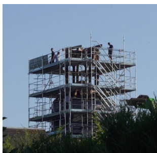
Pose des paliers de circulation le 11 juillet 2025
