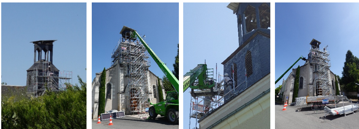
Pose du nouvel échafaudage début juillet 2025
