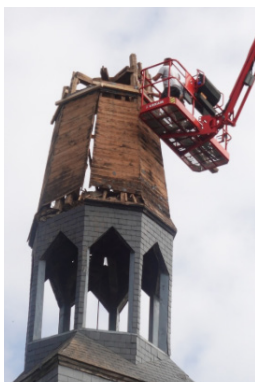
Titre photos du démontage de la flèche et protections des cloches
