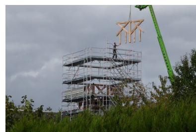
Reconstruction à neuf du campanaire et mise en place des côtés latéraux
