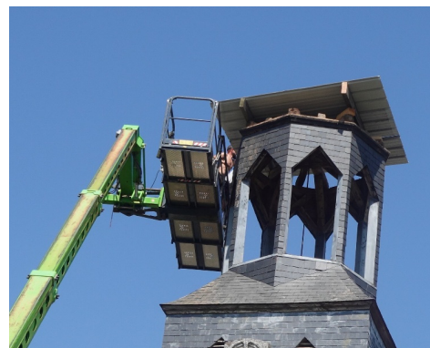
Titre photos du démontage de la flèche et protections des cloches
