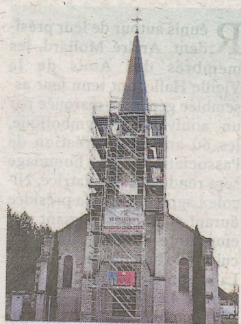
La rénovation du clocher devrait être terminée fin avril. (Photo NR)
